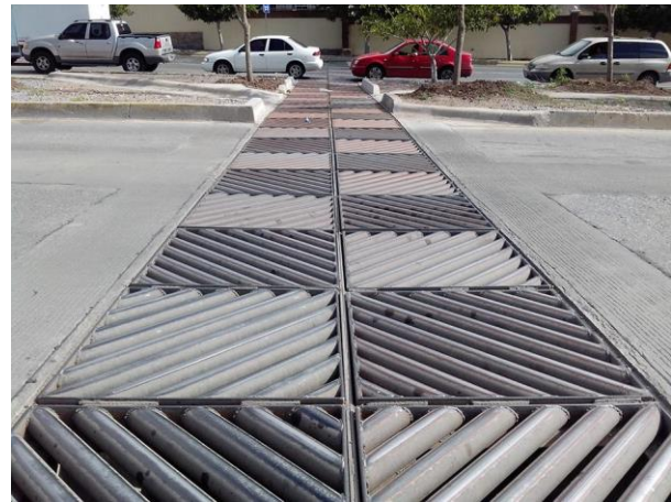
Ilustración 69. Alcantarilla en Av. La Cantera. Fuente: JMAS.
