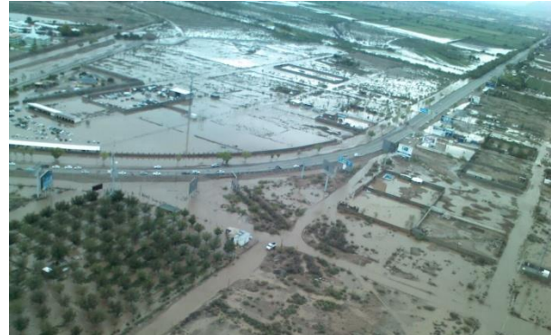
Ilustración 65. Inundación en Aeropuerto Internacional General Roberto Fierro Villalobos, 2013.
